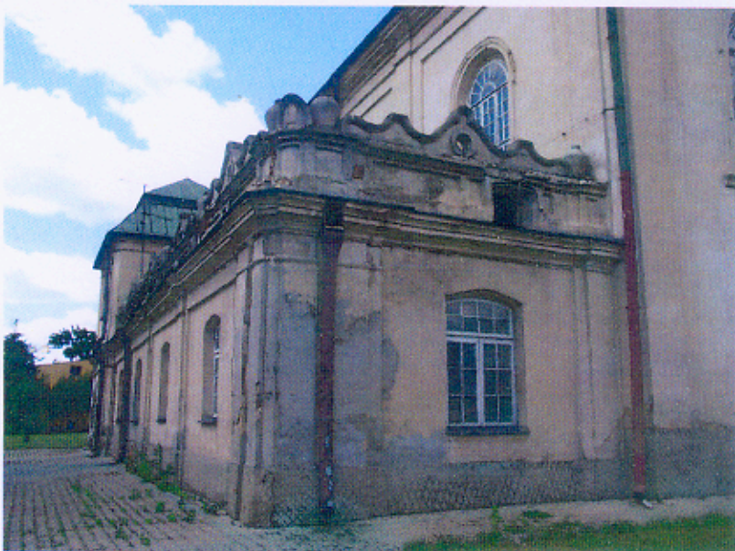
2. SYNAGOGA WIELKA OBECNIE MUZEUM, UL. CZERWONEGO KRZYŻA 5A, WŁODAWA WIDOK OGÓLNY ELEWACJI POŁUDNIOWEJ. WIDOCZNE USZKODZENIA NA ELEWACJI SYNAGOGI, BABIŃCA I NAROŻNEJ WIEŻY - ALKIERZA. STAN ISTNIEJĄCY CZERWIEC 2016.
