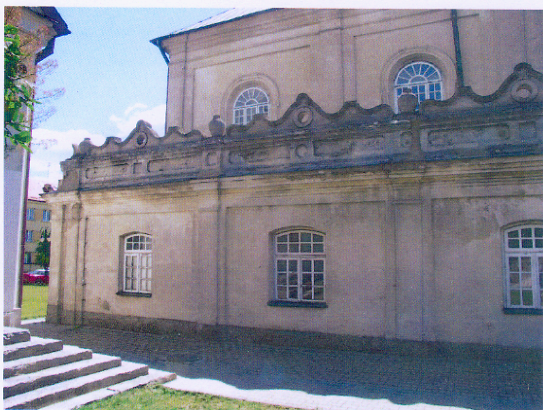
4. SYNAGOGA WIELKA OBECNIE MUZEUM, UL. CZERWONEGO KRZYŻA 5A, WŁODAWA WIDOK OGÓLNY ELEWACJI PÓŁNOCNEJ. WIDOCZNE USZKODZENIA NA ELEWACJI SYNAGOGI, BABIŃCA I NAROŻNEJ WIEŻY - ALKIERZA. STAN ISTNIEJĄCY CZERWIEC 2016.
